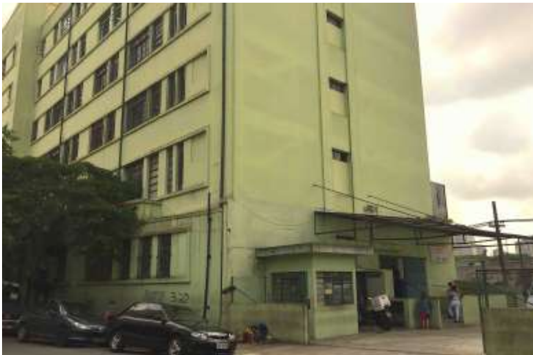
Foto N° 2: Vista geral do prédio da AMA – Sé.
