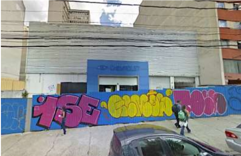
Foto N° 8: Local a ser reformado para a implantação da UPA Vila Buarque.
