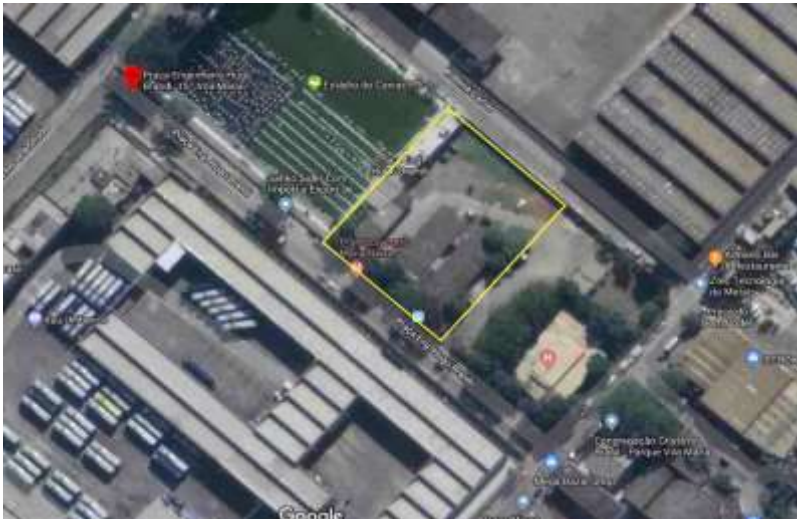
Foto N° 25: Vista aérea da UBS Jardim onde será implantada a UPA Vila Maria Baixa. Fonte: Google Maps
