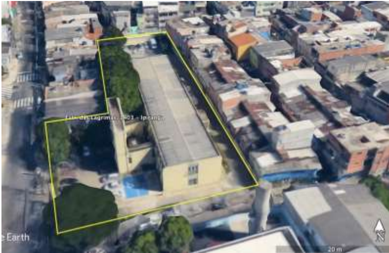
Foto N° 19: Vista aérea da UBS Sacomã, mostrando os pátios da frente e dos fundos e o recuo lateral, à esquerda. Fonte: Google Earth.
