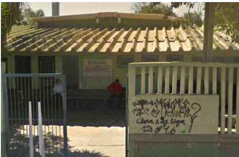
Foto N° 25: UBS a ser reformada para a implantação da UPA Vila Maria Baixa. Fonte: Google Maps.
