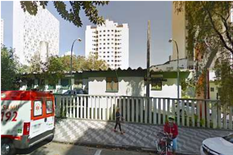
Foto N° 5: Vista geral do Pronto Socorro Municipal Dr. Álvaro Dino Almeida – Pronto Socorro da Barra Funda.
