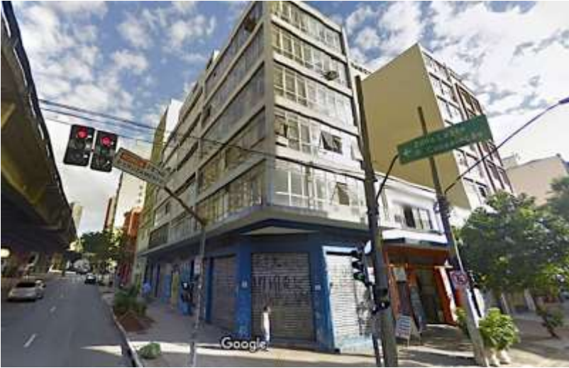
Foto N° 32: Prédio onde será instalado o CCI Centro, mostrando as vizinhança nas ruas Amaral Gurgel à esquerda e General Jardim à direita.
