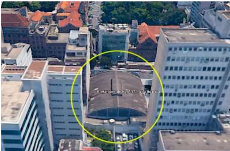
Foto N° 9: Vista aérea do local a ser reformado para a implantação da UPA Vila Buarque. Fonte: Google Earth.
