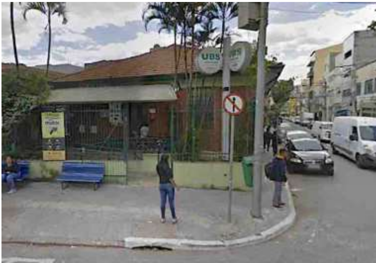
Foto N° 51: Fachada da UBS Bom Retiro.
