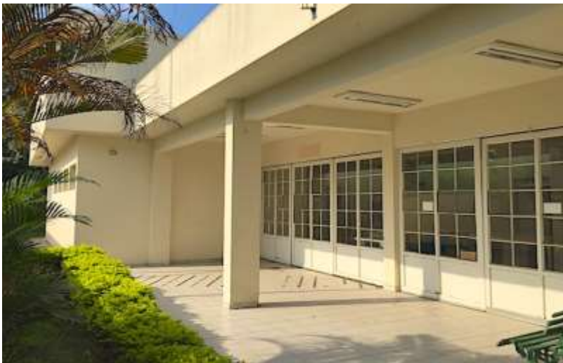
Foto N° 39: Vista da lateral esquerda do prédio onde será instalado o CCI Norte.
