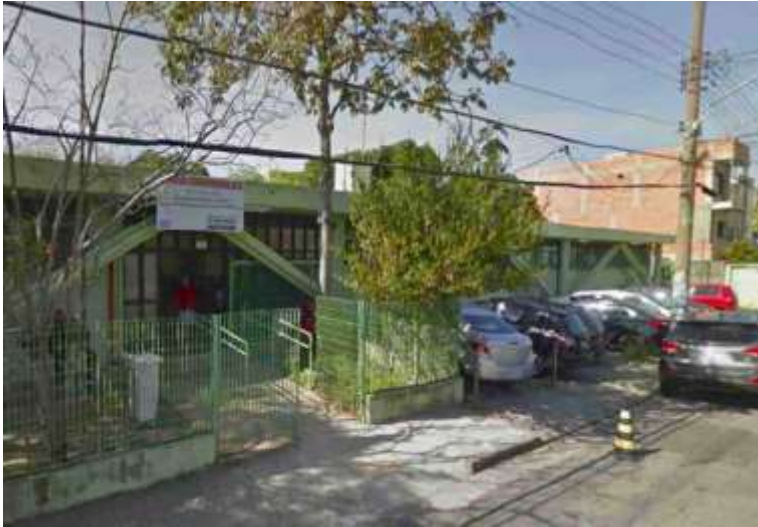
Foto N° 67: UBS Parque Arthur Alvim. Entrada da Rua Henrique Jacobs N° 269.
