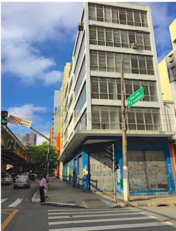
Foto N° 31: Prédio localizado na Rua Amaral Gurgel N° 344 que será reformado para instalação da CCI Centro.
