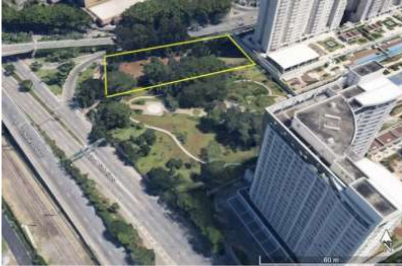
Foto N° 44: Vista aérea do terreno onde será construído o CCI Sul. Fonte: Google Earth.
