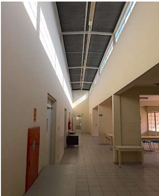
Foto N° 37: Vista interna do prédio onde será implantado o CCI Norte, com destaque à iluminação de teto.
