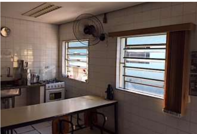
Foto N° 49: Sede da Coordenadoria Regional de Saúde Norte. Refeitório sem tela mosquiteiro nas janelas e portas.
