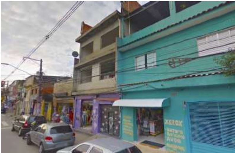
Foto N° 20: Vizinhança da UBS Sacomã, constituída basicamente de pontos comerciais, na Estrada das Lágrimas.
