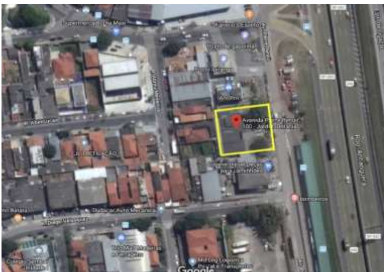
Foto N° 70: Vista aérea da UBS Parque Anhanguera. Fonte: Google Maps.
